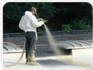
Applicazione spray di espansi
