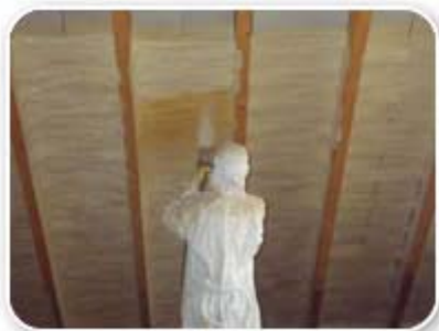
Isolamento sottotetto
